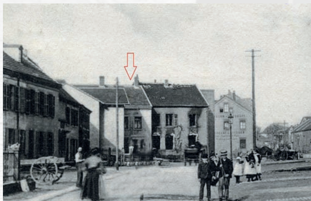
Das ehemalige Wohnhaus (Pfeil) in der Rodener Straße/Ecke Lebacher Straße, heute abgerissen. Hier befindet sich heute ein kleiner Parkplatz.
